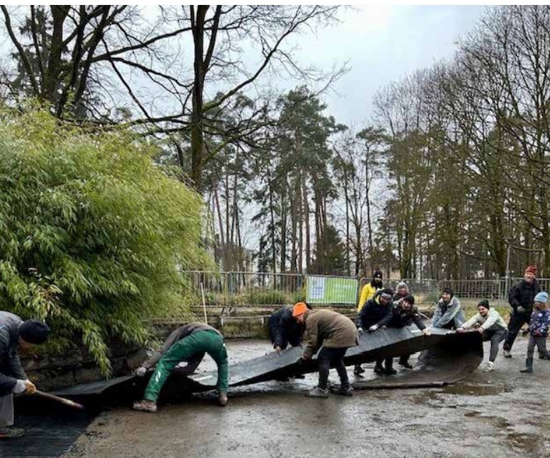
Die Entfernung der Bitumenmatten war der schwierigste Job.
