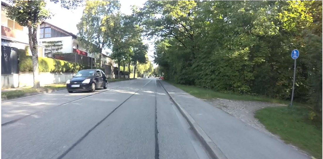
Abbildung 38: Fehlende Bordsteinabsenkung (Quelle: Eigene Aufnahme)
