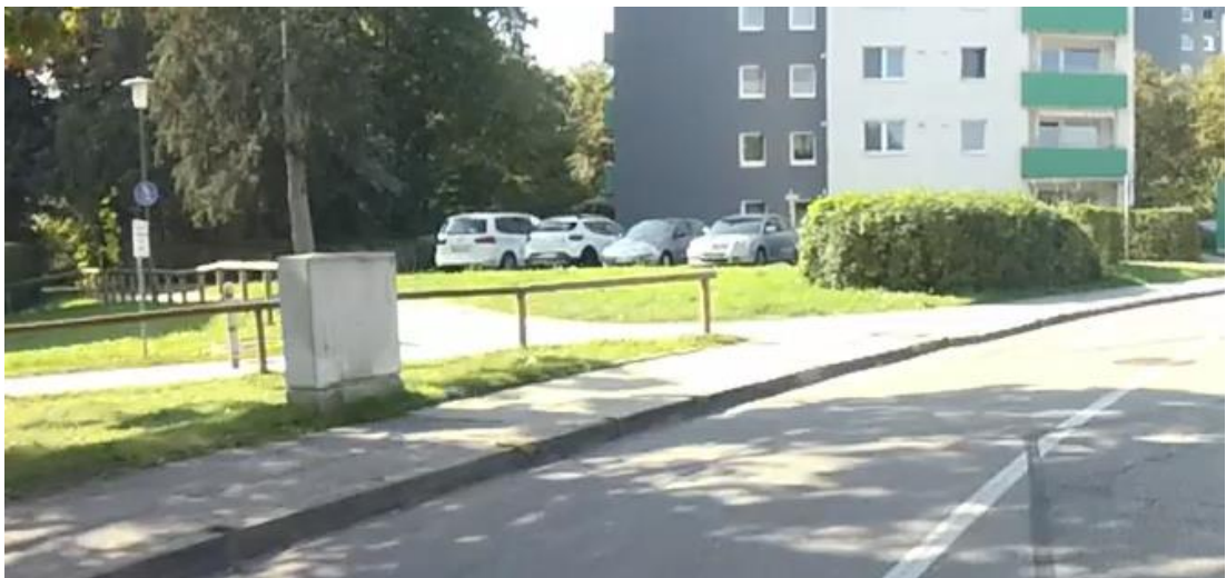
Abbildung 39: Fehlende Bordsteinabsenkung und Wegweisung (Quelle: Eigene Aufnahme)
