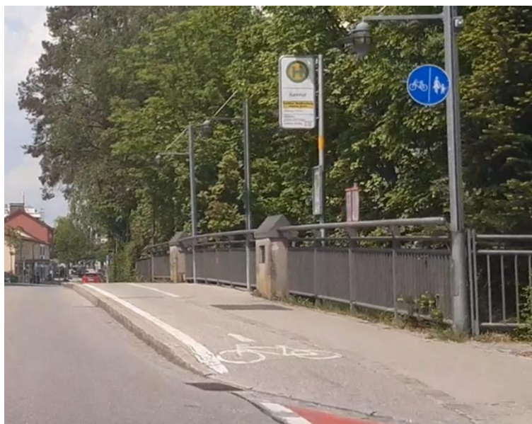
Abbildung 49: Beispiel Bushaltestelle Bahnhof (Bayernbrücke) (Quelle: Eigene Aufnahme)
