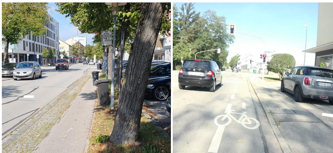
Abbildung 40: Zu schmale Radverkehrsanlagen (links: zusätzl. Einschränkung durch Mülltonnen) (Quelle: Eigene Aufnahme)
