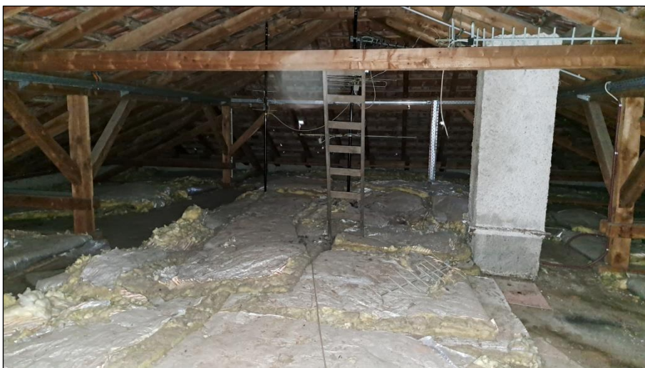
Blick in den Dachstuhl des Gebäudes
