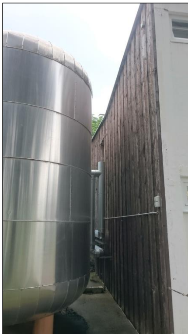
Abb. 4 Holzverkleidung mit Windfachblech an der nach Südwesten ausgerichteten Firstseite des Gebäudes
